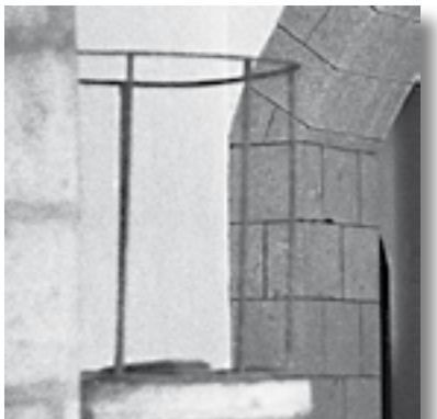
Detalle de la austera barandilla del púlpito.
