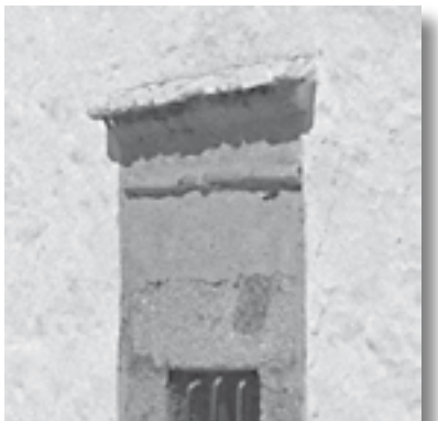
Detalle del sencillo guardapolvo que cubre una de las ventanas.
