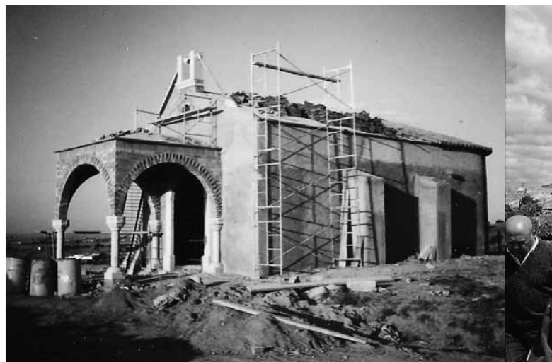
Obras de la Ermita
