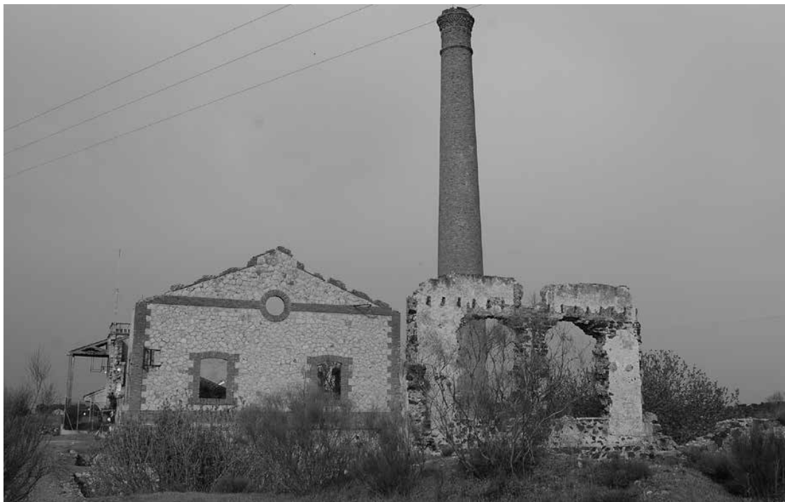
Figura 4. Central eléctrica junto al pozo Triunfo
